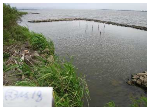
植生が回復していない消波工
