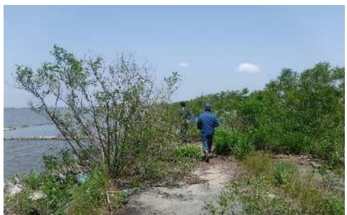
消波工にいたる湖岸の状況
